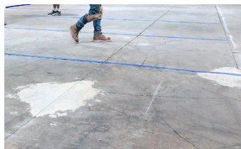
Definición del área de reparación mediante corte de sierra y cinta adhesiva.
