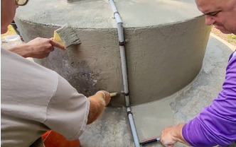
Aplique Surface Armor® con una brocha y luego un Squeegee Trowel para alisar las marcas de la brocha.
