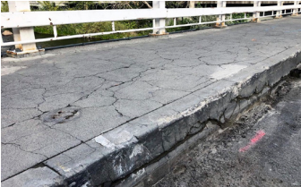
Acera muy agrietada y con delaminado del concreto.
