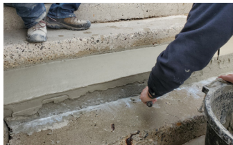
Dando los toques finales a la reparación.
