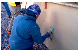
Se usa una paleta flotante para lograr el acabado deseado antes de la aplicación final de Vetrolfluid®.
