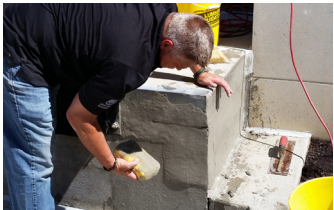
Acabado final con cepillo tipo brocha.
