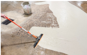
La aplicación de Surface Armor® es rápida y sencilla con un GST Squeegee Trowel.
