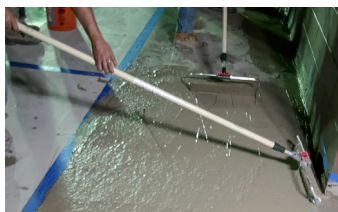
Aplicación de una segunda capa de Elephant Armor®.
