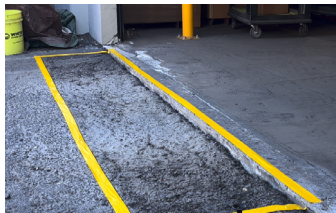
Instalación de una rampa del almacén.
