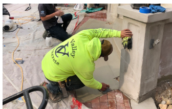
Aplicando el terminado en paredes y columnas.
