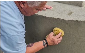
Se utiliza una esponja húmeda para alisar la Surface Armor™ y darle una textura suave.
