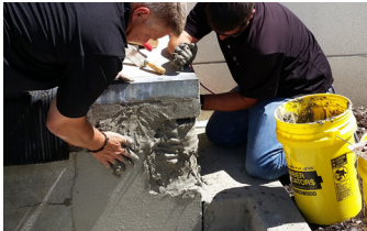
Aplicando Elephant Armor® DOT en la superficie vertical sin cimbrar.
