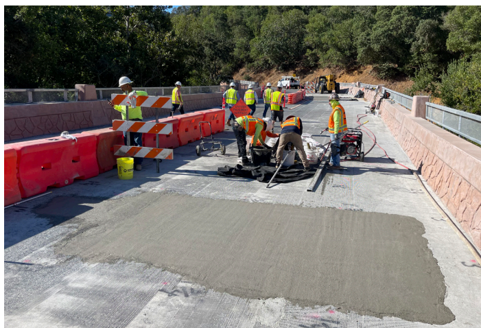
Las zonas con barras de refuerzo expuestas se rellenan y encapsulan con Elephant Armor® - DOT antes de la aplicación final de Elephant Armor® - DOT.
