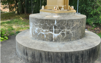
Hormigón envejecido que muestra grietas y calcio y formación de moho debido a la retención de agua.
