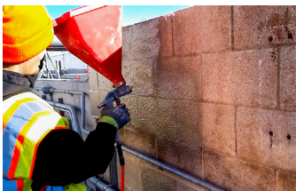
Surface Armor™ se rocía sobre la pared de bloques degradados después de una aplicación inicial de Vetrolfluid®.
