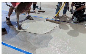
Los rodillos calibrados GST se utilizan para aplicar Elephant Armor® con un grosor constante de 1/4" (6mm).
