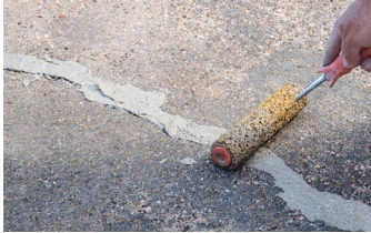
Elephant Armor® se utiliza para rellenar las grietas profundas.
