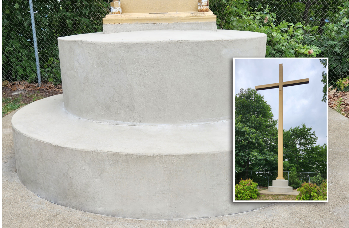
La facilidad de uso de Surface Armor y su rápido tiempo de fraguado permitieron reparar la base de forma permanente en menos de 2 horas, con una interrupción mínima del santuario.
