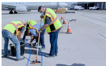
Relleno de grietas con Elephant Armor® utilizando un rodillo y un GST Squeegee Trowel.
