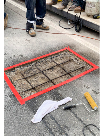
Area de reparación limpia, estable y "seca saturada de superficie" (SSD) antes de la colocación de Elephant Armor®.
