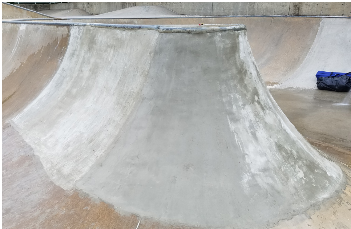
Restauración completa del concreto deteriorado con Elephant Armor® DOT.
