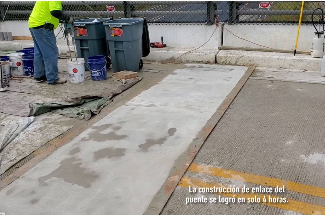
La mezcla fluida de Elephant Armor®- DOT garantiza la encapsulación de acero.
