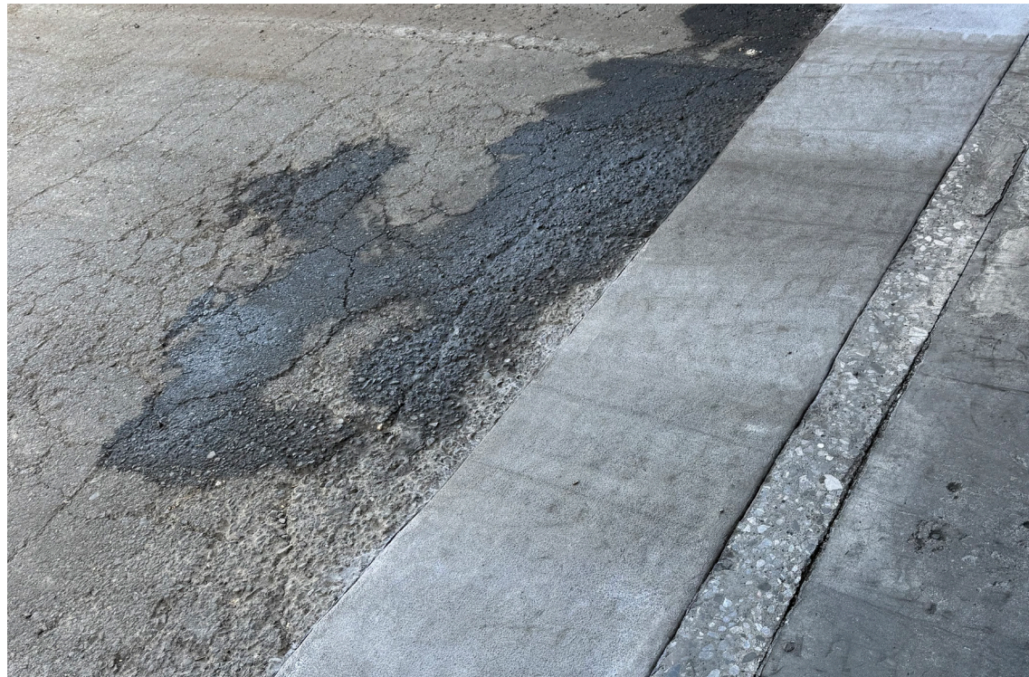
Transición de la rampa terminada y lista para su uso en solo dos horas.
