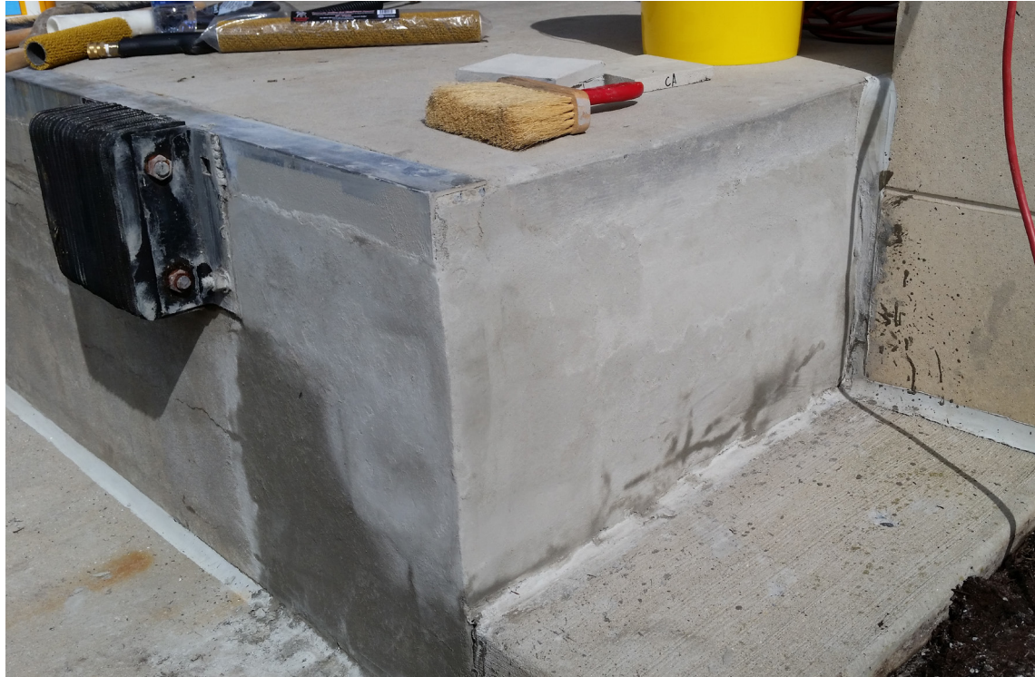
El andén finalmente reparado. Al no requerirse cimbra, la ejecución del trabajo fue muy rápida y su secado y endurecimiento acelerado evita interrumpir las operaciones.
