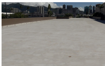
Reparación completa y lista para usar.
