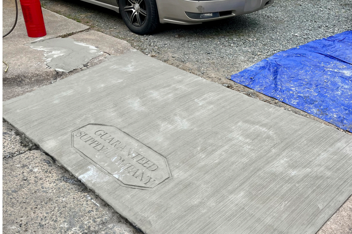
Reparación terminada, estampada con el logo de Guaranteed Supply Company. Ecobeton® - USA VetroFluid® se aplica como último paso después de que la reparación Elephant Armor® Mortar haya logrado un curado completo.
