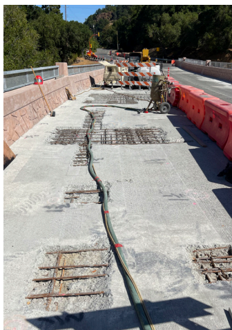
Area de reparación estructural del acero expuesto en el tablero del puente.
