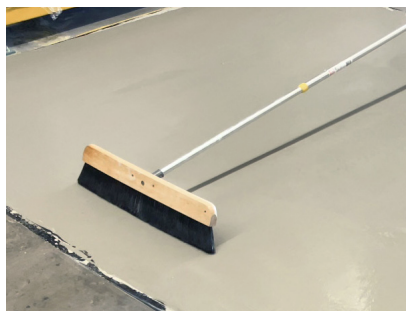
El acabado con escoba proporciona una superficie antideslizante.
