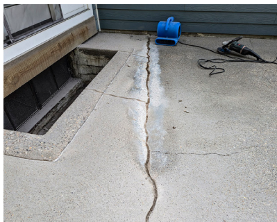
Elimine cualquier material suelto de las grietas con una esmeriladora y un soplador de hojas.
