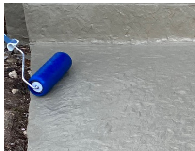
Los rodillos texturizados también se pueden utilizar para obtener un acabado decorativo.
