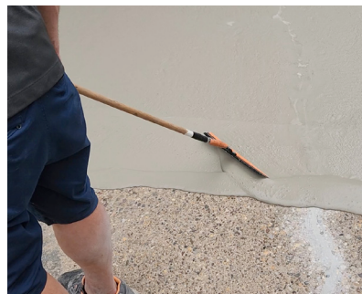
Aplique una capa de 1-2 mm de Surface Armor™ al sustrato y aplique una segunda capa después del curado.
