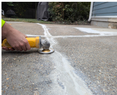
Pule las grietas rellenas para eliminar cualquier borde irregular o muy delgado.
