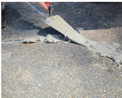
Rellene las grietas con Elephant Armor® DOT utilizando una llana o paleta.
