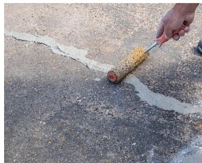
Empuje y aplane el Elephant Armor® DOT en las grietas con un rodillo.
