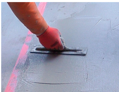
Se puede utilizar una llana para igualar las superficies existentes.
