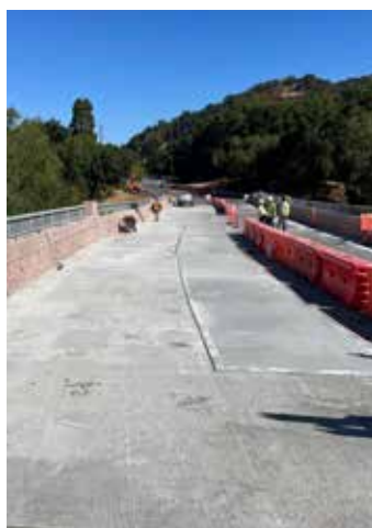
El primer recubrimiento está curado y listo para la segunda capa de 1/2".
