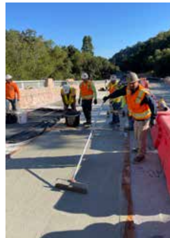
La primera capa de 1/2" de Elephant Armor®- DOT aplicándose al tablero del puente.
