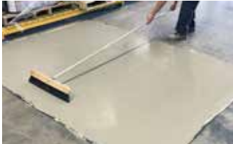
Se hace un acabado antideslizante con una escoba después de la segunda capa de Surface Armor™.
