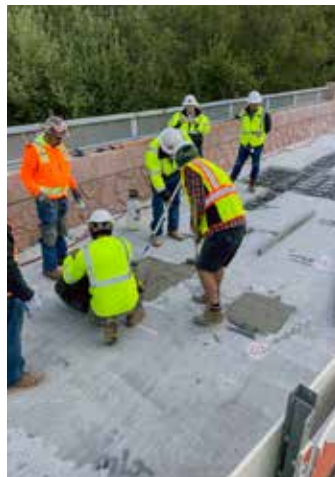
Aplicación de Elephant Armor® - DOT como material de relleno alrededor del acero expuesto.
