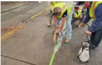
Se hacen cortes limpios alrededor del perímetro del área a reparar.
