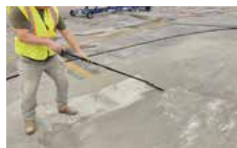
Se aplica una capa de Surface Armor™ sobre toda el área reparada (rellenada).
