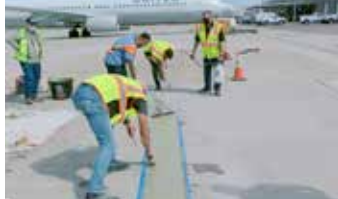
La capa de Elephant Armor® se coloca utilizando una llana para bordes y un Squeegee.
