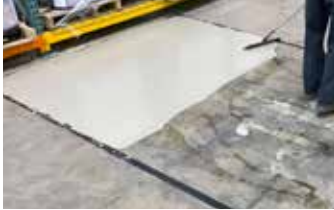
La primera capa de Surface Armor™ con un GST Squeegee Trowel.
