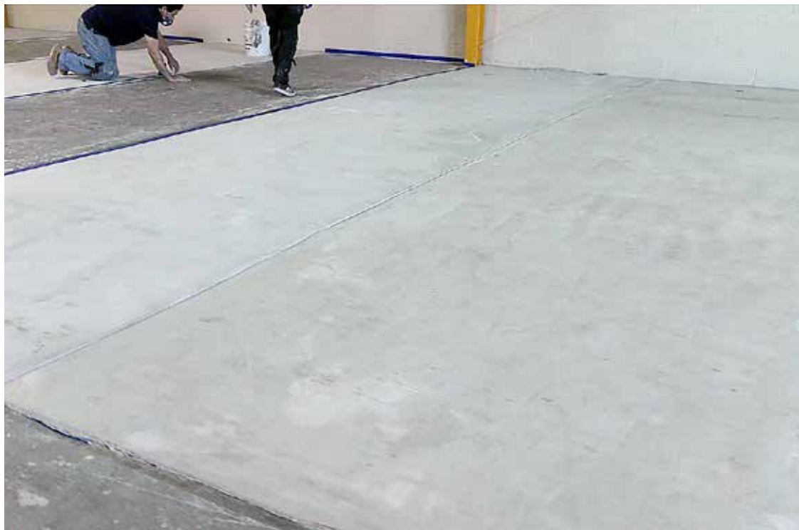
El Elephant Armor® DOT se aplicó en secciones lo que permitió el uso ininterrumpido del almacén.
