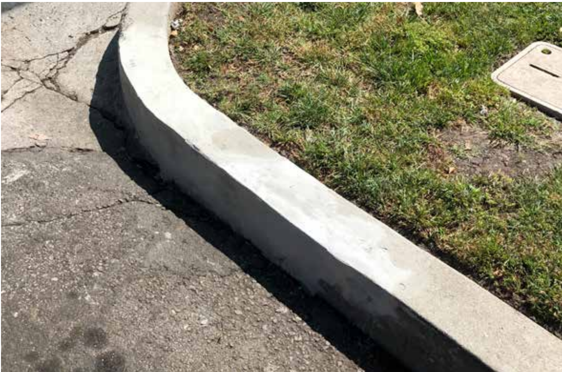
Reparación del bordillo utilizando Elephant Armor® - DOT en menos de 1 hora.
