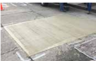
Reparación completada en dos horas y abierta al tráfico en cuatro horas.
