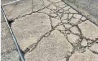
Panel de hormigón severamente degradado, listo para una aplicación de 'relleno y tapado'.
