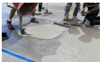
Los rodillos calibrados GST se utilizan para aplicar Elephant Armor® con un grosor constante de 1/4" (6mm).
