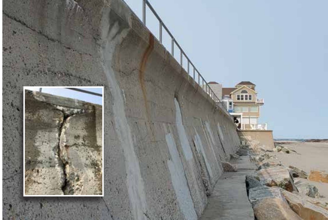
Agrietamientos por efectos del ambiente marino y estar expuesto por décadas a agua salada fueron reparados con Elephant Armor® DOT lográndose un nuevo ciclo de vida para este antiguo rompeolas.
