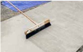
Después de usar un GST Squeegee Trowel para alisar la superficie, se aplica un acabado de escoba.
