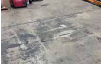
Panel del piso de una bodega dañada y antiestética antes de la repavimentación.
