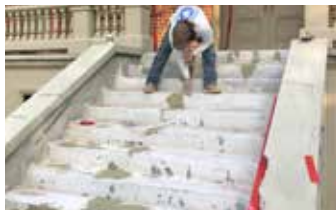
Relleno de grietas y oquedades antes del recubrimiento total.
