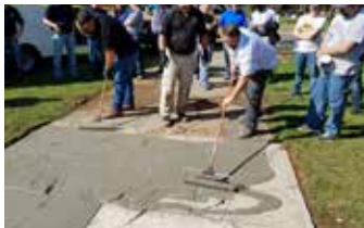
Aplicación de lechada de Elephant Armor® para relleno de grietas y en área general.
