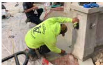
Aplicando el terminado en paredes y columnas.
