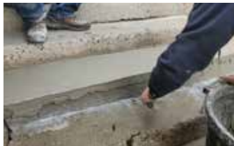
Dando los toques finales a la reparación.
