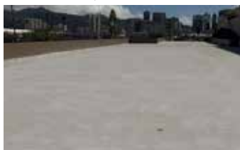
Reparación completa y lista para usar.
