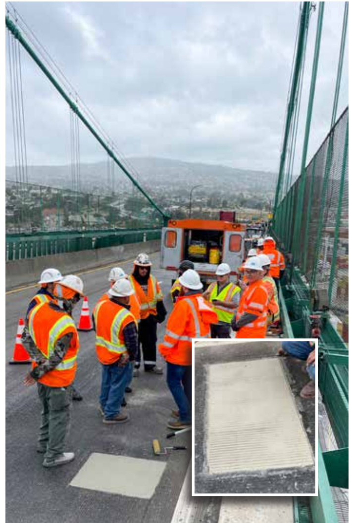
La facilidad de uso y el rápido tiempo de fraguado de Elephant Armor® - DOT permitieron reparar de forma definitiva el bache con una interrupción mínima del tráfico del puente. Este carril volvió a estar en servicio en menos de 3 horas.
