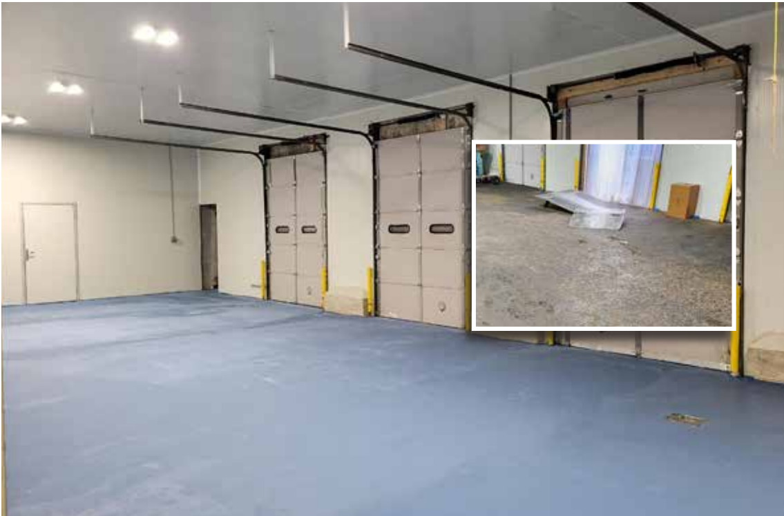
Surface Armor® es un micro-recubrimiento cementoso de alta resistencia que acepta pigmentos líquidos o en polvo. (no compatible con pigmentos granulares secados por pulverización).
