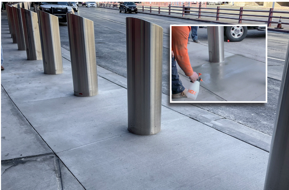
Paneles terminados que muestran una nueva apariencia. La foto del recuadro muestra la aplicación de Ecobeton® - USA Vetrofluid® como paso final del sistema Surface Armor™.
