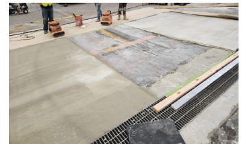
El último panel está listo para ser llenado y nivelado con los dos paneles exteriores.
