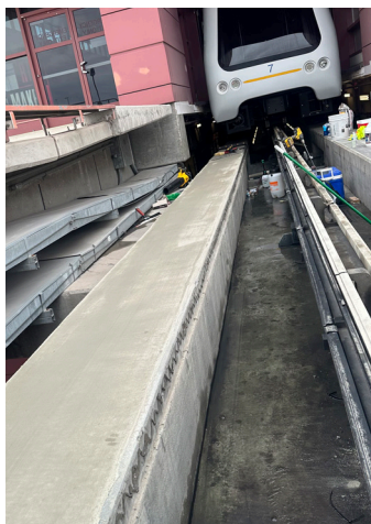
Ecobeton® - USA Vetrofluid® rociado antes de la aplicación de Surface Armor™.
