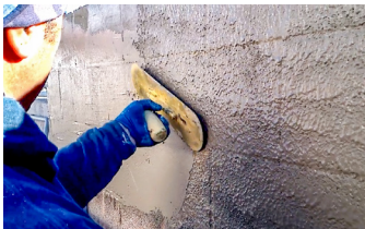
Se usa una llana para esparcir Surface Armor™ y lograr un espesor uniforme.
