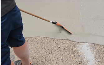
Se aplican dos capas de Surface Armor™ con un GST Squeegee Trowel.
