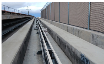
Se aplicaron dos capas de Surface Armor™ para mayor durabilidad y textura.
