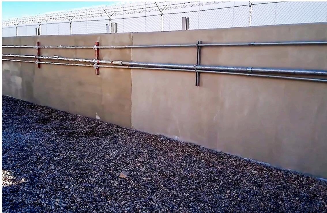
Una pared de bloques de CMU recién repavimentada con una apariencia 'como nueva' después de eliminar las grietas visuales y la decoloración. La pared ahora es impermeable y estructuralmente sólida.
