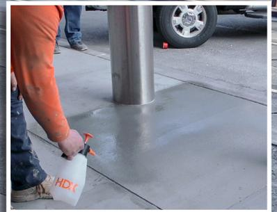
Paneles terminados que muestran una nueva apariencia. La foto del recuadro muestra la aplicación de Ecobeton® - USA Vetrofluid® como paso final del sistema Surface Armor™.
