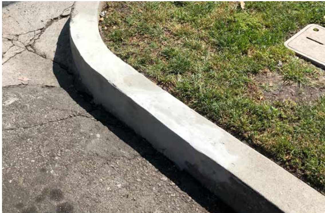
Reparación del bordillo en menos de 1 hora.
