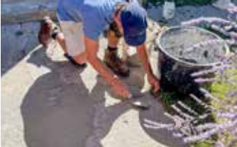
Elephant Armor® DOT se utiliza para rellenar todos los desprendimientos y grietas profundas.
