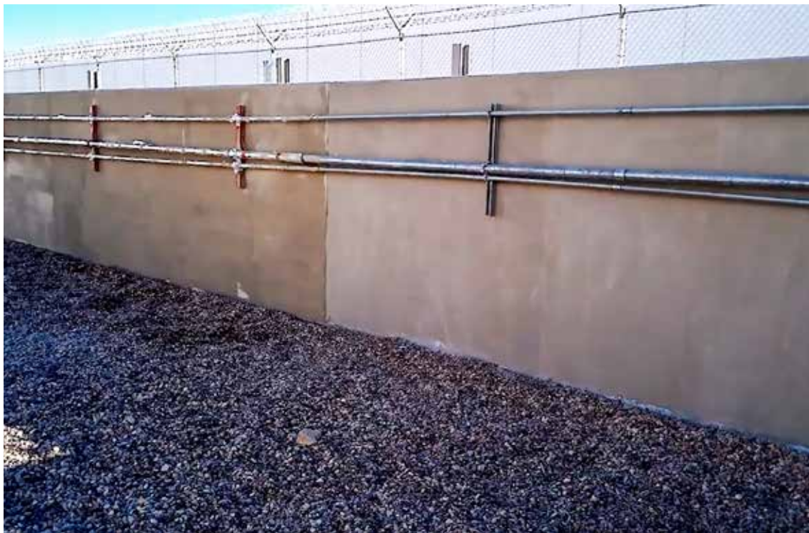
Una pared de bloques de CMU recién repavimentada con una apariencia 'como nueva' después de eliminar las grietas visuales y la decoloración. La pared ahora es impermeable y estructuralmente sólida.
