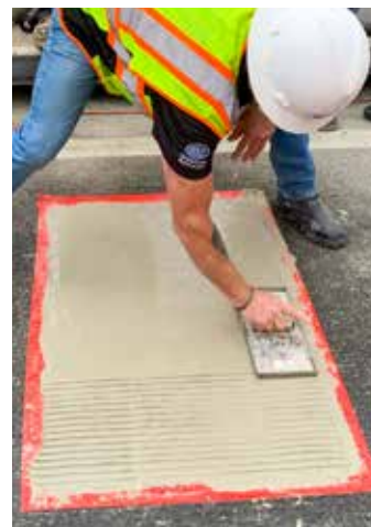
Usar una lana con ranuras para simular la textura existente de la superficie del puente.
