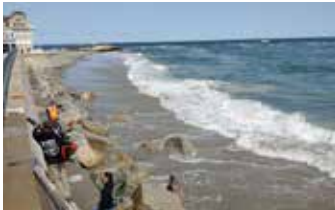
Reparación completada durante el ciclo de marea baja.
