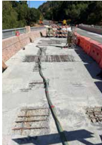
Área de reparación estructural del acero expuesto en el tablero del puente.
