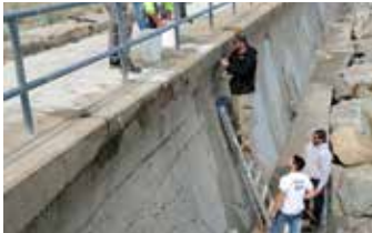
Aplicación de Elephant Armor® en el área de reparación.
