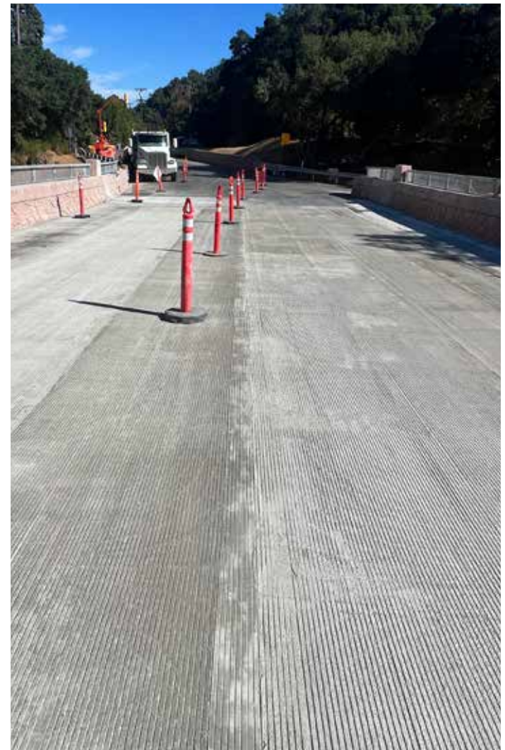
Finalización de la repavimentación del tablero del puente en aproximadamente una semana.
