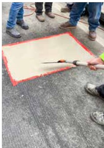
Elephant Armor® se coloca y nivela fácilmente con GST Squeegee Trowels.
