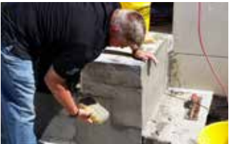
Acabado final con cepillo tipo brocha.
