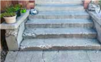
Escalera muy desconchada y degradada, debidamente limpiada y sellada con Ecobeton® Vetrofluid®.
