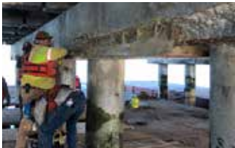
Aplicación del Elephant Armor® sobre la superficie debidamente preparada y con el primario.
