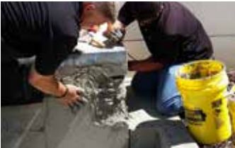
Aplicando Elephant Armor® en la superficie vertical sin cimbrar.
