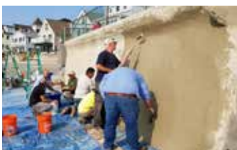
Aplicación y acabado final mediante el rodillo de textura GST.
