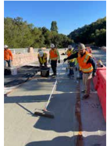
La primera capa de 1/2" de Elephant Armor aplicándose al tablero del puente.
