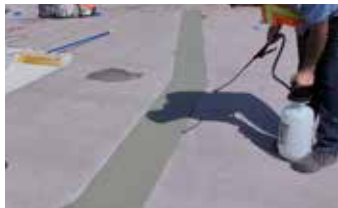
Acabado de la reparación Elephant Armor® con una aplicación de Ecobeton® Vetrofluid®.
