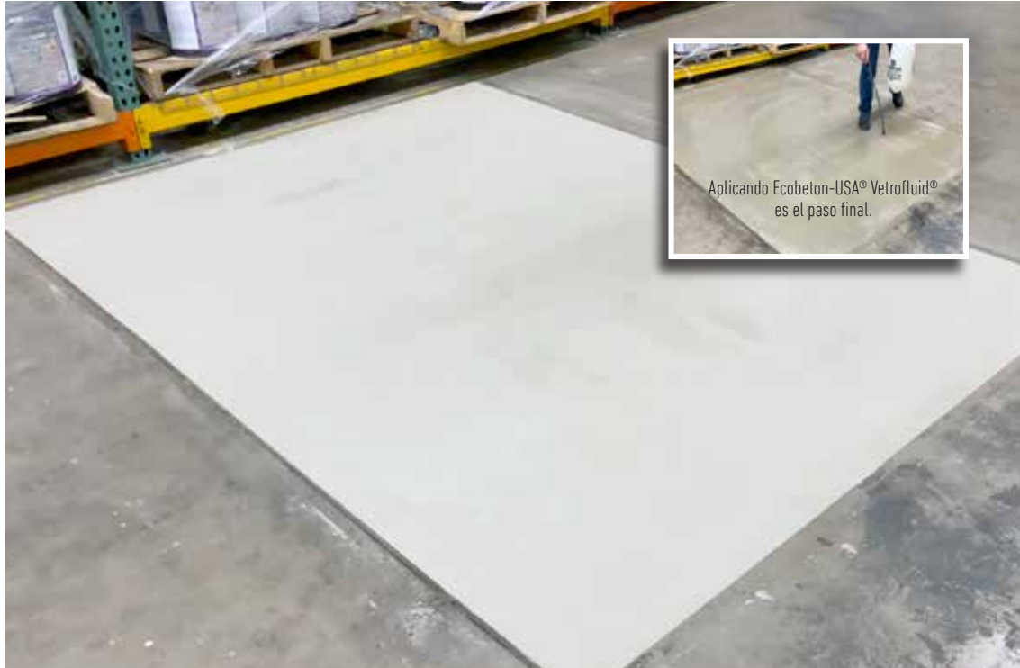
El panel del piso de la bodega volvió a tener una apariencia 'nueva' y está lista para el tráfico pesado de montacargas. Se hizo un acabado con una escoba para reducir el riesgo de 'resbalones y caídas'.
