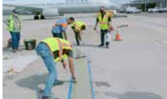
La capa de Elephant Armor® se coloca utilizando una llana para bordes y un Squeegee.
