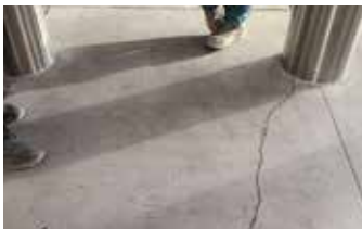
Panel de acera antes del relleno de grietas con la primera capa de Surface Armor™.
