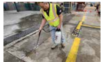
Se aplica una capa de Ecobeton® - USA Vetrofluid® para estabilizar el hormigón existente.
