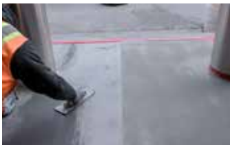
Usando una llana para completar la primera capa de Surface Armor®.
