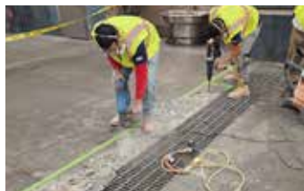
Todo el concreto inestable suelto se desmenuza para proporcionar una superficie sólida.
