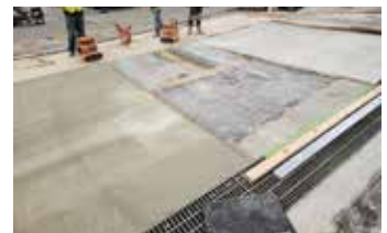
El último panel está listo para ser llenado y nivelado con los dos paneles exteriores.
