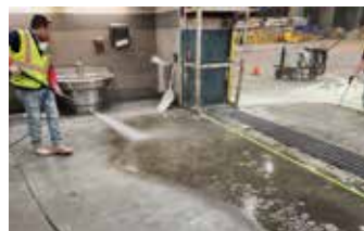
Se lava el área a reparar y se retira todo el material suelto.
