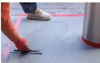
Aplicando la segunda capa de Surface Armor™ a la superficie antes de pasar la escobilla.
