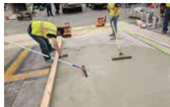
Elephant Armor® se coloca y nivela fácilmente con GST Squeegee Trowels y Rodillos.
