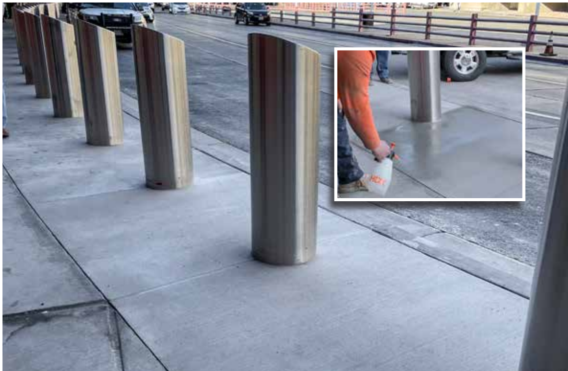
Paneles terminados que muestran una nueva apariencia. La foto del recuadro muestra la aplicación de Ecobeton® - USA Vetrofluid® como paso final del sistema Surface Armor™.
