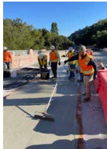
La primera capa de 1/2" de Elephant Armor aplicándose al tablero del puente.
