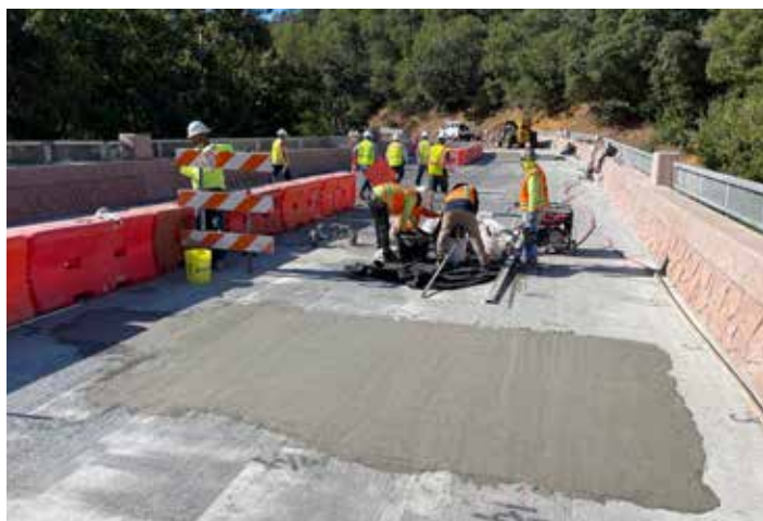
Las zonas con barras de refuerzo expuestas se rellenan y encapsulan con Elephant Armor® antes de la aplicación final de Elephant Armor® DOT.
