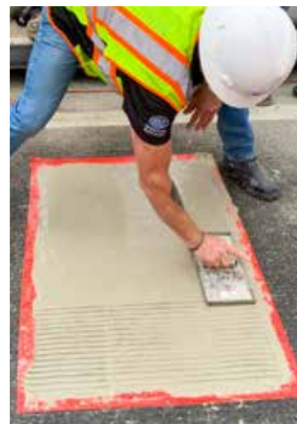
Usar una llana con ranuras para simular la textura existente de la superficie del puente.
