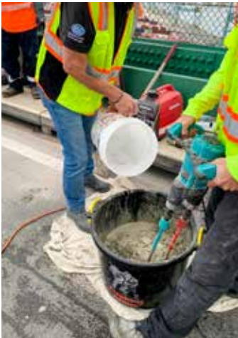
Es fácil preparar el Elephant Armor®, solo agregue agua. Usar el ColloMix Xo 55 Duo para generar el alto cizallamiento necesario para lograr una mezcla homogénea.
