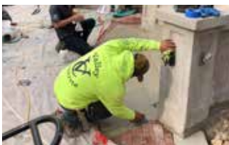
Aplicando el terminado en paredes y columnas.
