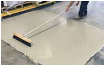
Se hace un acabado antideslizante con una escoba después de la segunda capa de Surface Armor™.
