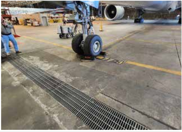
Foto que muestra daños extensos en el concreto alrededor de los desagües, incluida una depresión de 'carga puntual' de 3" en el área de estacionamiento en el tren de morro del avión.
