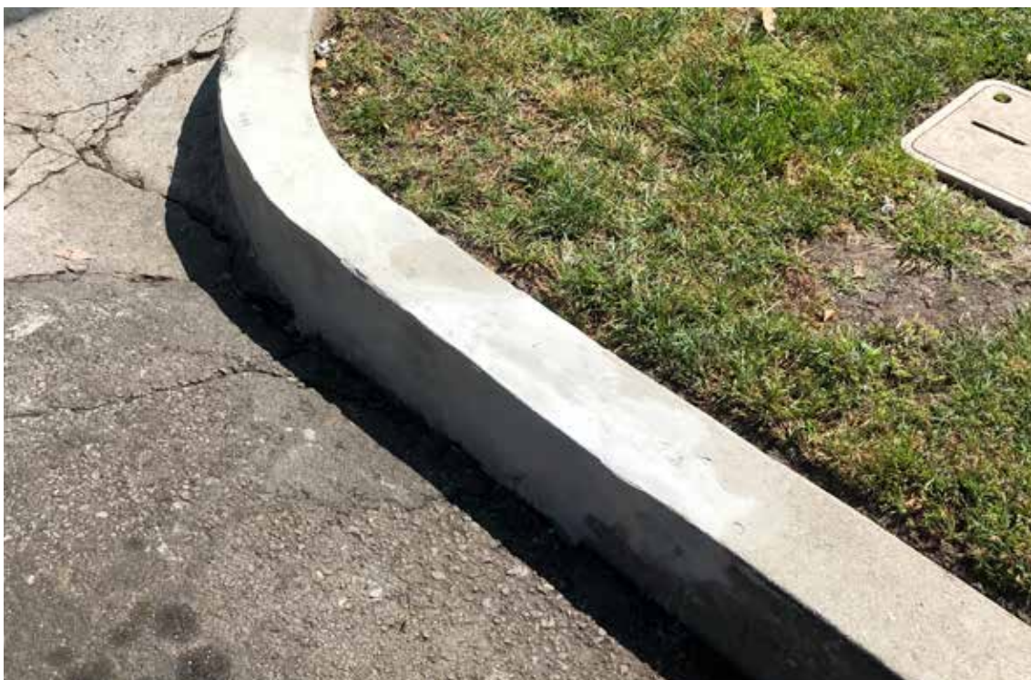
Reparación del bordillo en menos de 1 hora.
