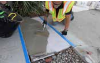
Aplicación de Elephant Armor® utilizando un Rodillo deTextura GST.
