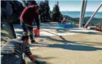
Elephant Armor® aplicado con rodillos y llanas GST.
