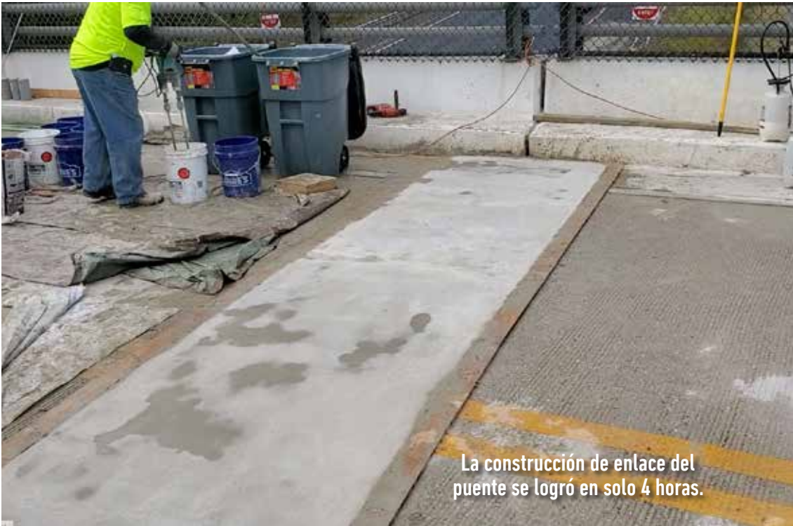
La mezcla fluida de Elephant Armor® garantiza la encapsulación de acero.
