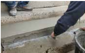
Dando los toques finales a la reparación.
