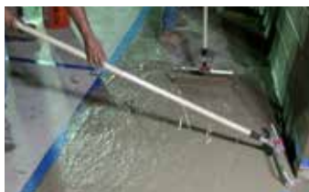
Aplicación de una segunda capa de Elephant Armor®.
