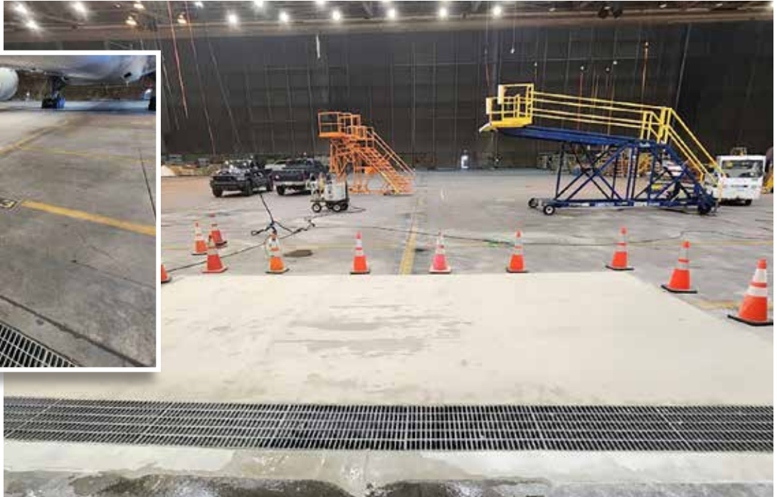
Foto que muestra daños extensos en el concreto alrededor de los desagües, incluida una depresión de 'carga puntual' de 3" en el área de estacionamiento en el tren de morro del avión.
