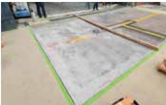
Se aplica una capa de EA Primer sobre el área de reparación.
