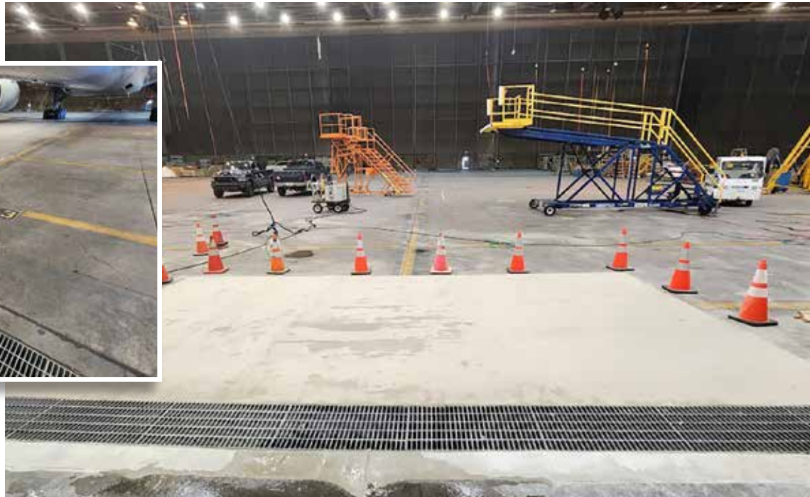
Foto que muestra daños extensos en el concreto alrededor de los desagües, incluida una depresión de 'carga puntual' de 3" en el área de estacionamiento en el tren de morro del avión.
