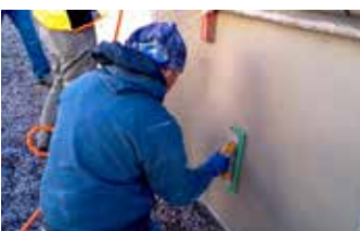
Se usa una paleta flotante para lograr el acabado deseado antes de la aplicación final de Vetrofluid®.
