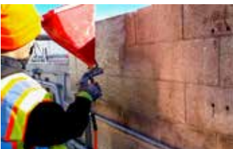
Surface Armor™ se rocía sobre la pared de bloques degradados después de una aplicación inicial de Vetrofluid®.
