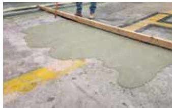
Elephant Armor® se aplica en tres paneles para rellenar y nivelar el área de reparación.
