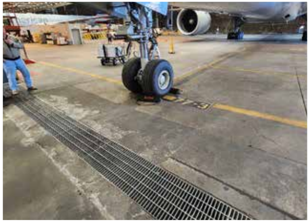
Foto que muestra daños extensos en el concreto alrededor de los desagües, incluida una depresión de 'carga puntual' de 3" en el área de estacionamiento en el tren de morro del avión.
