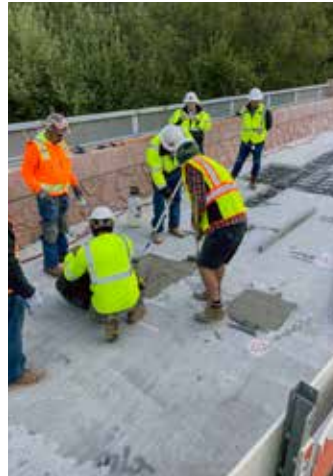
Aplicación de Elephant Armor® como material de relleno alrededor del acero expuesto.
