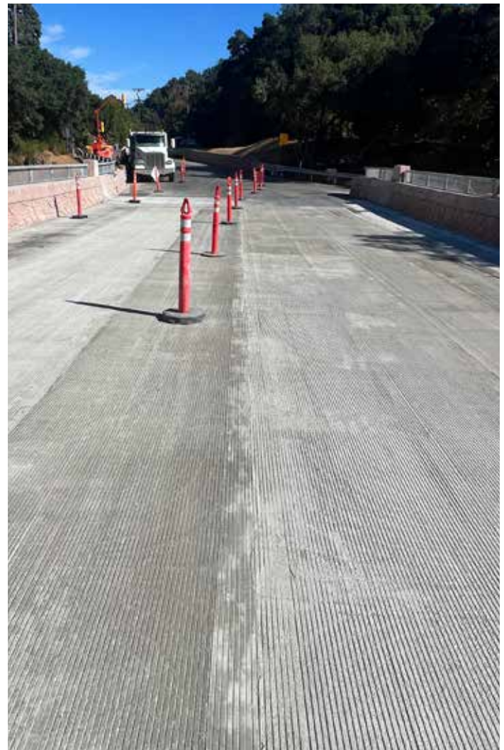
Finalización de la repavimentación del tablero del puente en aproximadamente una semana.
