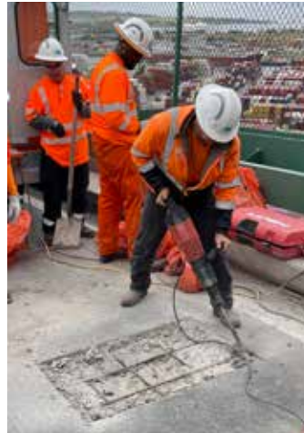
Retirar la superficie dañada y limpiar cualquier material suelto con una escoba y un soplador.
