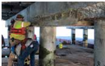
Aplicación del Elephant Armor® sobre la superficie debidamente preparada y con el primario.
