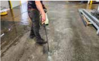
Limpiar el suelo con Pro-Grade Cleaner antes de aplicar Ecobeton® Vetrofluid.
