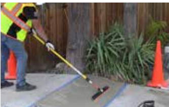
Preparación de la superficie para un acabado con escoba.
