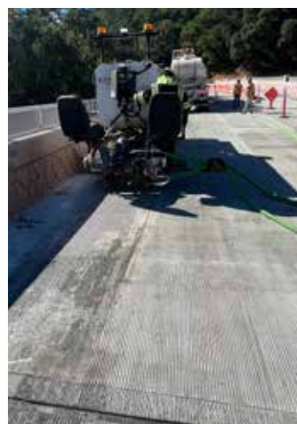
Una vez que la segunda capa se cure, una máquina ranuradora aplica la textura especificada.
