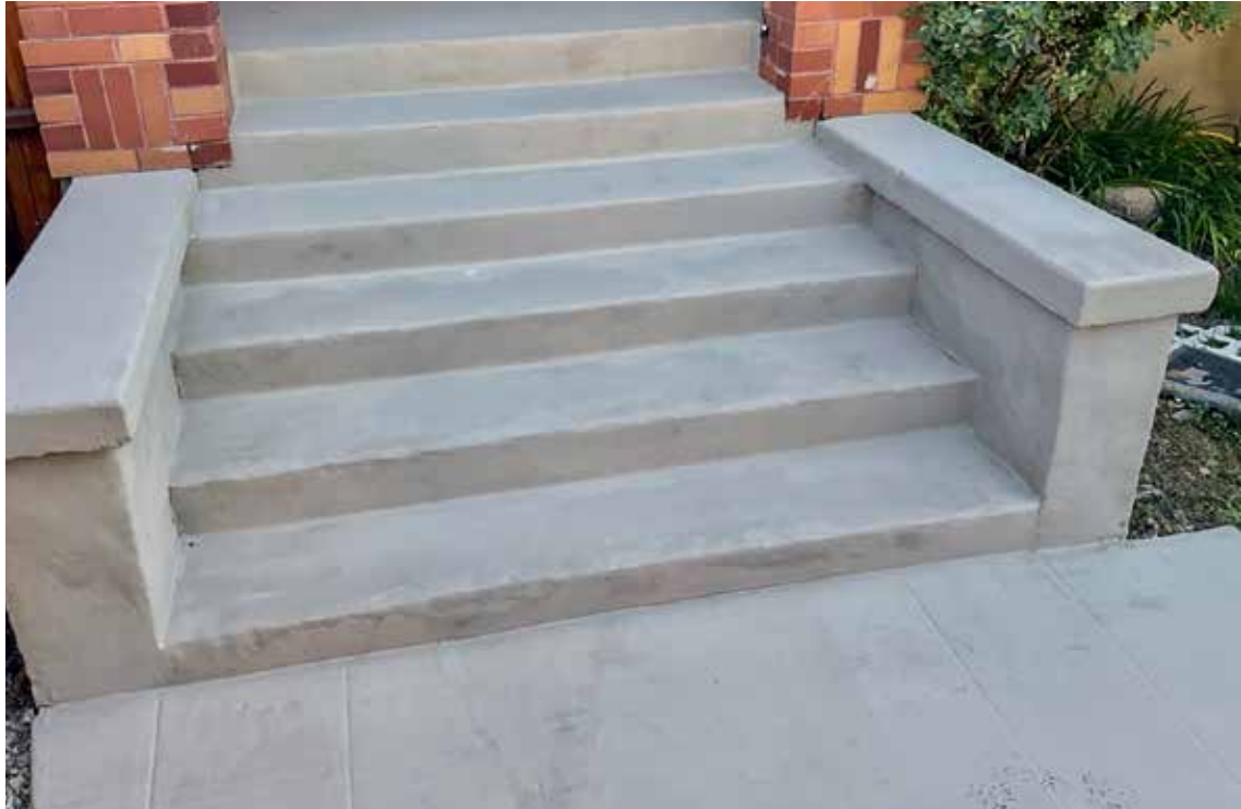
Restauración completa en 5 horas utilizando una bolsa de Elephant Armor® DOT y una bolsa de Surface Armor™ sin necesidad del tradicional costoso y largo proceso de deconstrucción/reconstrucción, alargando enormemente su ciclo de vida.
