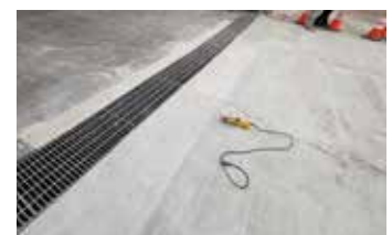
Reparación terminada lista para una mano de Ecobeton® - USA Vetrofluid®.
