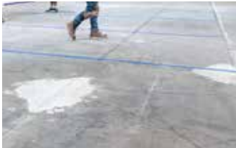
Definición del área de reparación mediante corte de sierra y cinta adhesiva.
