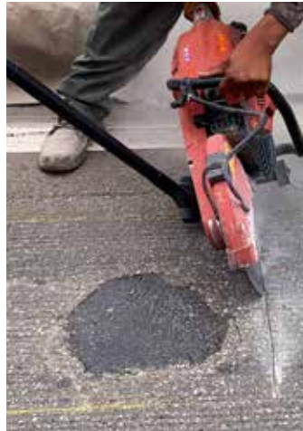
Es importante hacer cortes con una sierra alrededor del perímetro de la zona a reparar.
