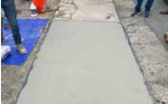
Después de rellenar previamente las grietas, se aplica una capa de Elephant Armor® de 1/4" a la superficie.
