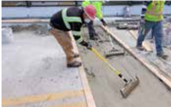
Colocación de material mediante Rodillos de Textura GST.
