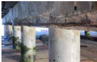
Concreto dañado y en mal estado removido y preparado para la aplicación de Elephant Armor®.
