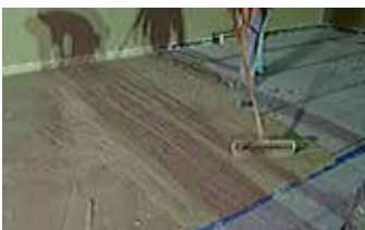
Aplicación de la primera capa de Elephant Armor® sobre la membrana impermeabilizante.
