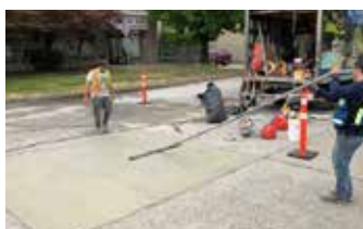
Terminado final del Elephant Armor en capa de 1/4" (6mm).
