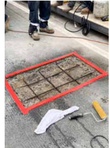
Área de reparación limpia, estable y "seca saturada de superficie" (SSD) antes de la colocación de Elephant Armor®.
