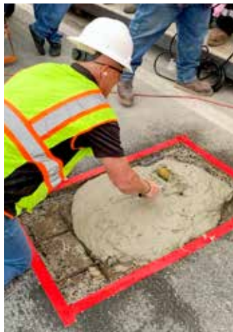
Usar un GST Textured Roller para colocar y extender uniformemente la mezcla de alto contenido de fibra de Elephant Armor®.
