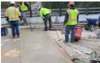
Poniendo el acabado final en el nuevo enlace del puente.
