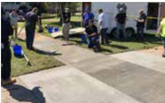
Afinado del Elephant Armor® con un jalador GST antes de aplicar un acabado escobillado.
