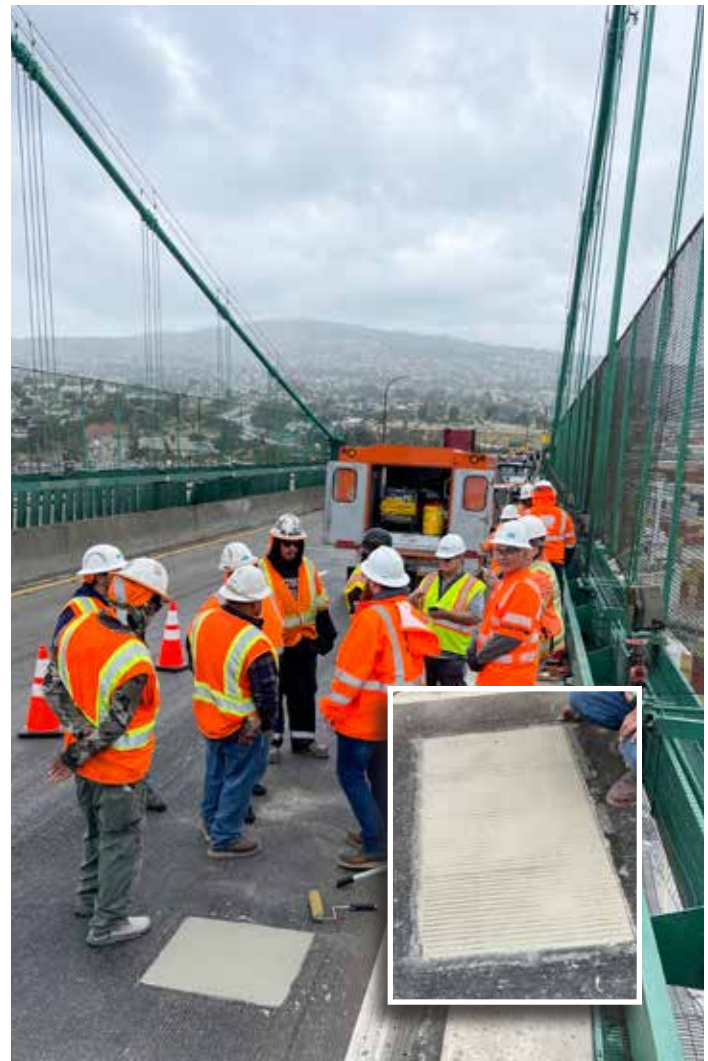
La facilidad de uso y el rápido tiempo de fraguado de Elephant Armor permitieron reparar de forma definitiva el bache con una interrupción mínima del tráfico del puente. Este carril volvió a estar en servicio en menos de 3 horas.
