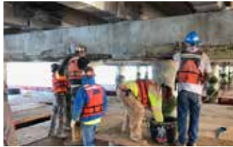
Aplicación de una lechada primer antes de recibir el Elephant Armor®.
